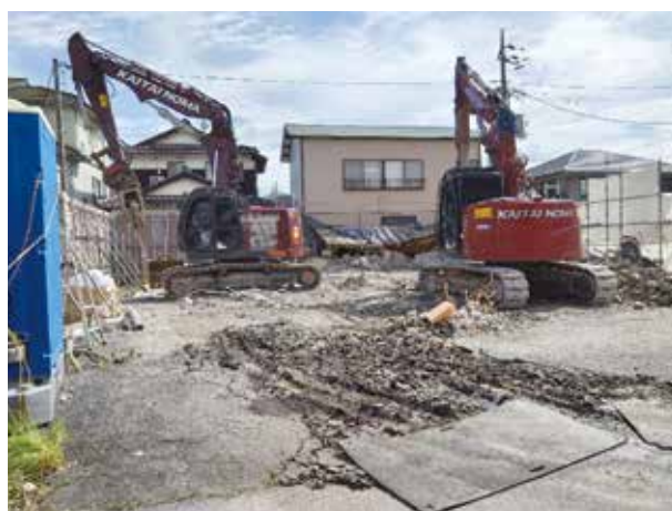
解体工事の様子
